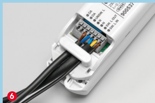
6 Sluit de voedingskabel aan op de led-driver voor noodverlichting (nuldraad en stroomdraad) en zet de kabels vast met de snoerontlastingsklem.
