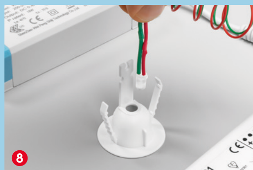
8 Installeer het led-controlelampje naast de armatuur aan het plafond.
