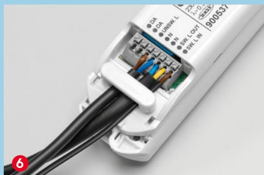
6 Collegare l'alimentazione elettrica al morsetto di alimentazione dell'inverter. Bloccare accuratamente il cavo con il relativo fermacavo.
