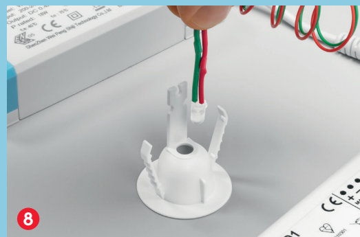
8 Installieren Sie die Status-LED in die Decke neben der Leuchte.
